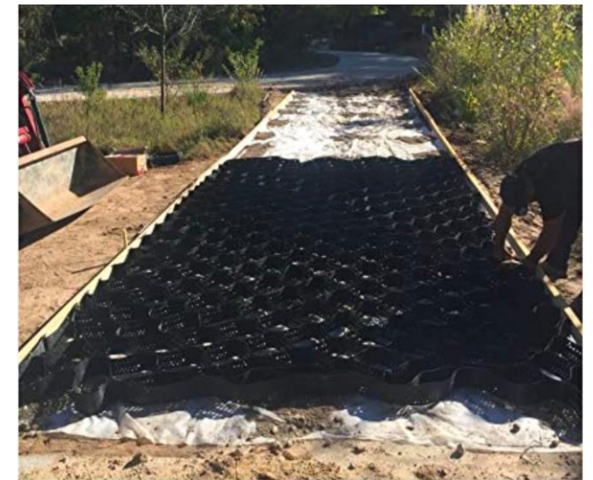
Sendero peatonal nuevo, mediante el uso de Geoseldas
